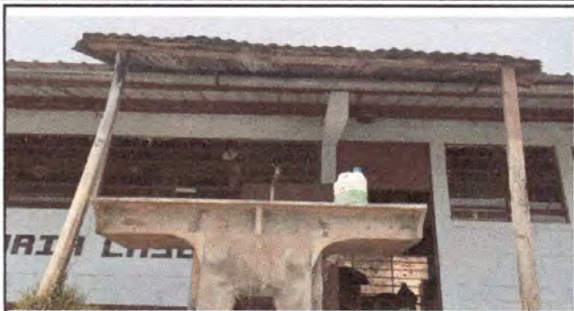
Foto 1: (Modulo 4) Sustitución de lamina por lamina troquelada y sustitución de elementos de fijación.
