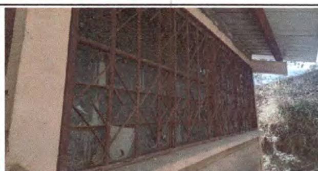
Foto 4: (Modulo 1,)Sustitución de balcones de metal. (Modulo 2,3,4,5,6,7) fabricación e instalación de balcones de hierro en ventanas
