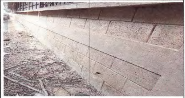
Foto 8: ( Modulo del 1, 2, 3, 4, 5, 6, 7) Impermeabilización de todos los modulos en la parte exterior e interior del centro educativo.
