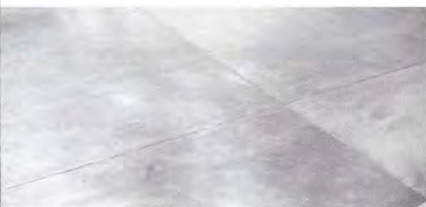
Foto No.9 MODULO 3 AULA SUSTITUCIÓN DE PISO DE TORTA
