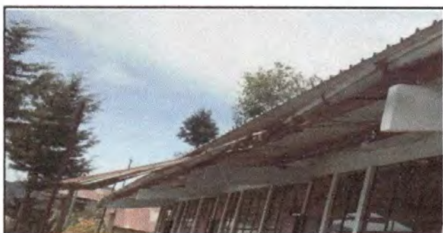
Foto 5: (Modulo 1,2,3,4,5,6,7) Sustitución de canal de metal y sustitución de bajada de agua y pluvial de metal por tubo PVC, sustitución de soporte o pescate de metal para canal.
