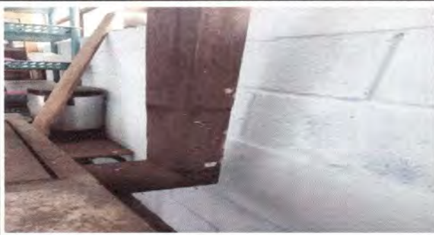
Foto7:(Modulo1) Sustitución de chimenea de metal
