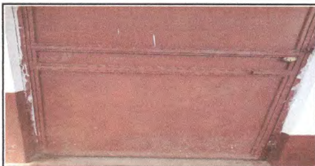
Foto 3: (Modulo del 1, 2, 3, 4, 5, 6, 7) Mantenimiento a estructura (fijado, cepillado y aplicación de pintura)
